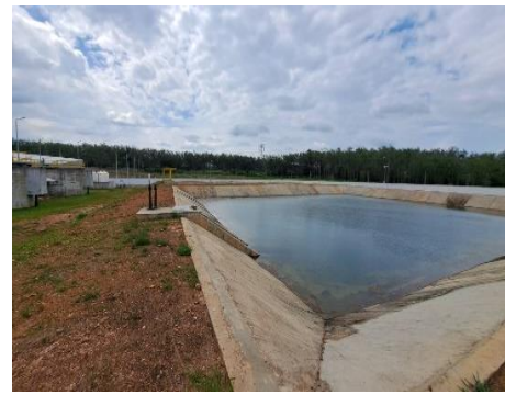
รูปที่ 5 บ่อพักน้ำทิ้ง (Holding Pond)
