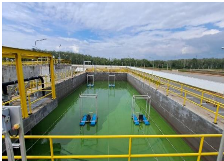
รูปที่ 2 ระบบบำบัดน้ำเสียส่วนกลางทางชีวภาพแบบตะกอนเร่ง (Activated Sludge)
