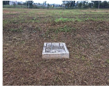
รูปที่ 1 บ่อตรวจสอบลักษณะน้ำเสียของโรงงานก่อนระบายน้ำเสียเข้าสู่ระบบบำบัดน้ำเสียส่วนกลาง
