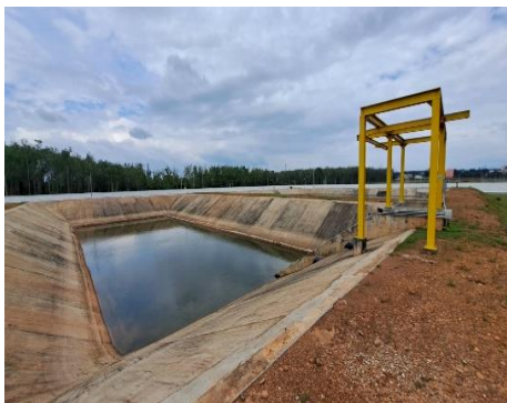
รูปที่ 6 บ่อพักน้ำทิ้งฉุกเฉิน (Emergency Pond)
