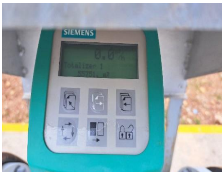
รูปที่ 3 เครื่องมือวัดอัตราการไหลของน้ำเสียก่อน-หลังออกจากระบบบำบัดน้ำเสียส่วนกลาง
