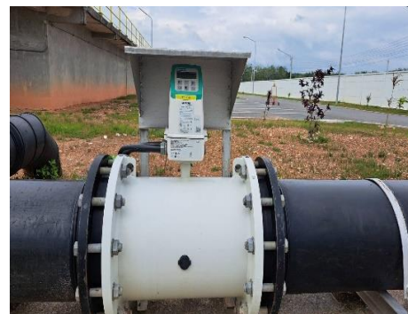
รูปที่ 3 เครื่องมือวัดอัตราการไหลของน้ำเสียก่อน-หลังออกจากระบบบำบัดน้ำเสียส่วนกลาง
