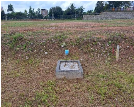
รูปที่ 1 บ่อตรวจสอบลักษณะน้ำเสียของโรงงานก่อนระบายน้ำเสียเข้าสู่ระบบบำบัดน้ำเสียส่วนกลาง
