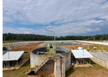
รูปที่ 2 ระบบบำบัดน้ำเสียส่วนกลางทางชีวภาพแบบตะกอนเร่ง (Activated Sludge)
